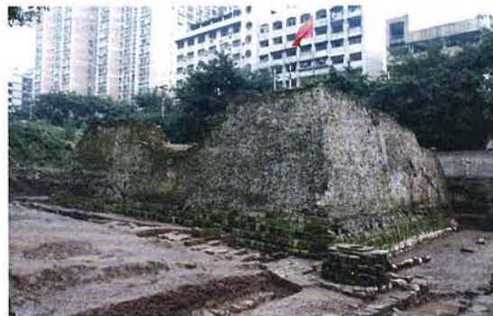
▶ 지붕 설치 전 황궁문(누각)의 한 쪽기단 모습. 기단은 불로 구운 벽돌을 쌓아 만들었다.
